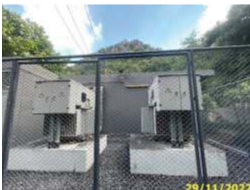
หม้อแปลงไฟฟ้าอาคารห้องเครื่อง 2
