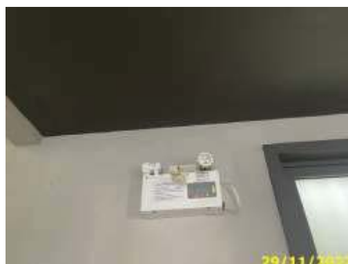
ระบบไฟฟ้าส่องสว่างฉุกเฉิน
