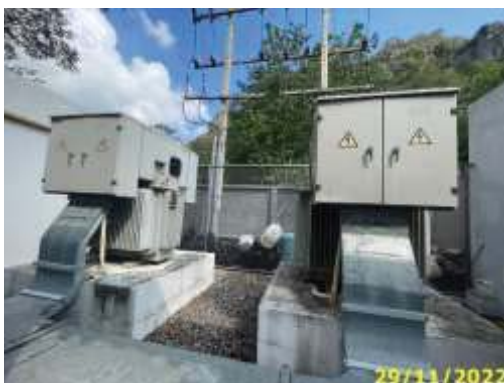
หม้อแปลงไฟฟ้าอาคารห้องเครื่อง 1
