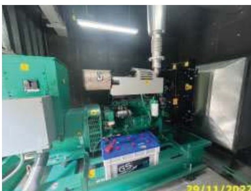
เครื่องกำเนิดไฟฟ้าสำรองฉุกเฉิน
